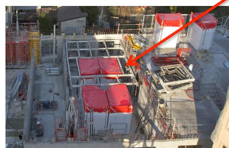
**Pose des Modules HVA lors de la phase GO : On n'aperçoit aucun voile béton entre les logements.**
